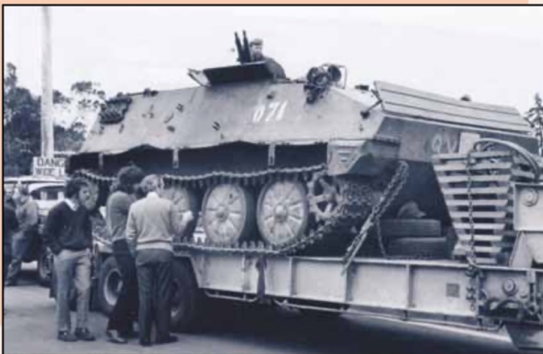
De YW531 op z'n dieplader op weg naar her Engineering Design Establishment. Duidelijk is te zien dat de rupsbandschermen ontbreken en dat de koplamp behoorlijk is beschadigd.
